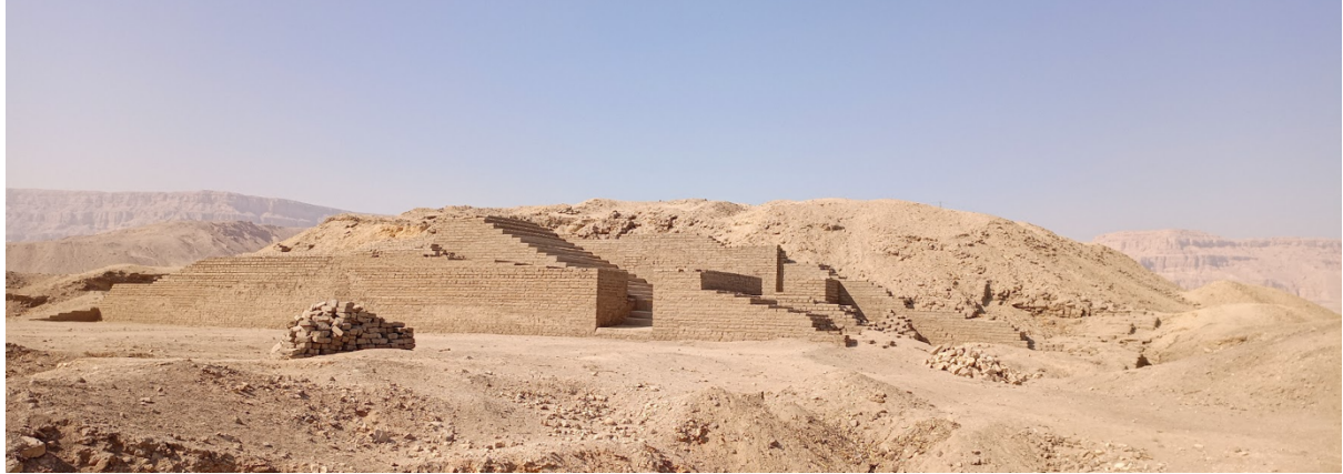
الشكل 1 "القصر الجنوبي" بعد الترميم عام 2023. (تصوير بيتر لاکوفارا)
