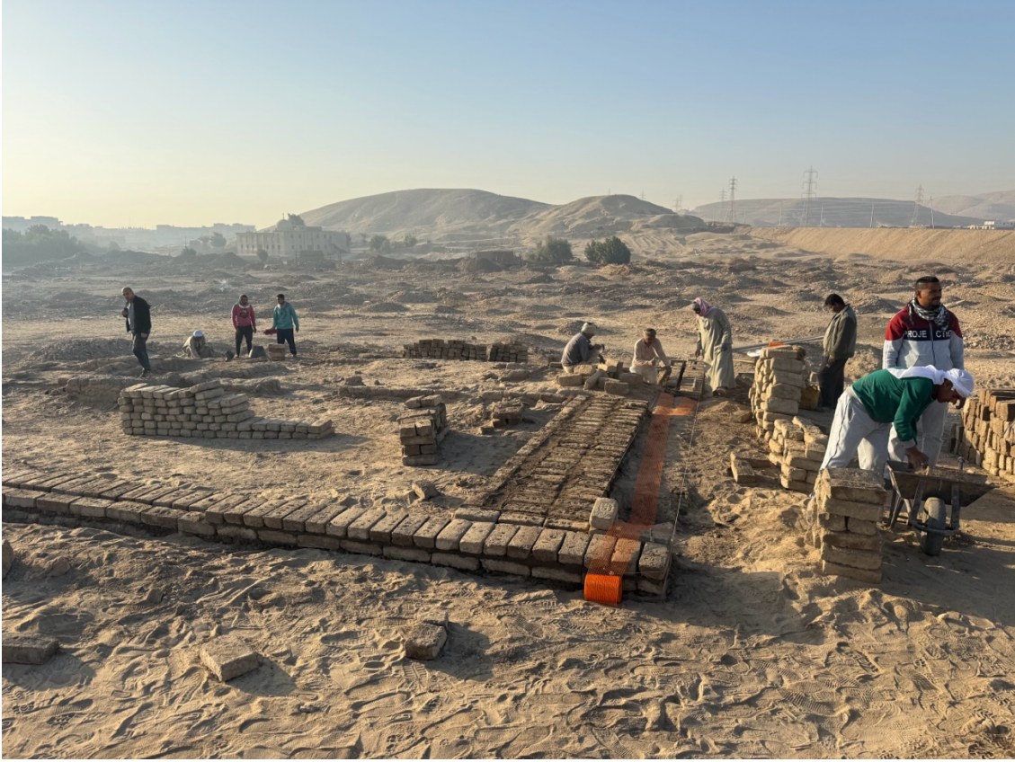
شكل ٢: أعمال الصون والترميم بجدران المكامن بالقصر الشمالي.
